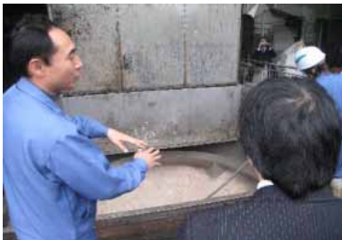
バイオ(メタンガス)発電視察 -やはり臭う08.11.28 熊本県
